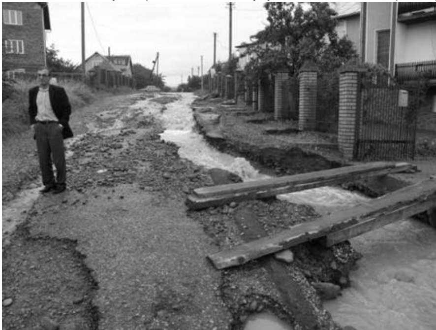
Фото 4. Наслідки паводку 2008 року [1].
